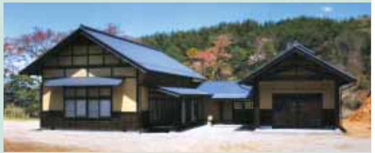
柿野沢構造改善センター。公会堂から新しく建替えられた。平成2年5月4日竣工、建面積212.9㎡、工費29,870,000円。
