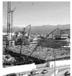
新庁舎建設工事の様子 (3.11現在)
