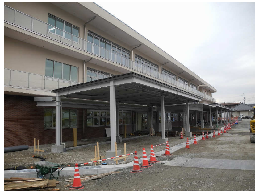
外構工事・西側キャノピー
