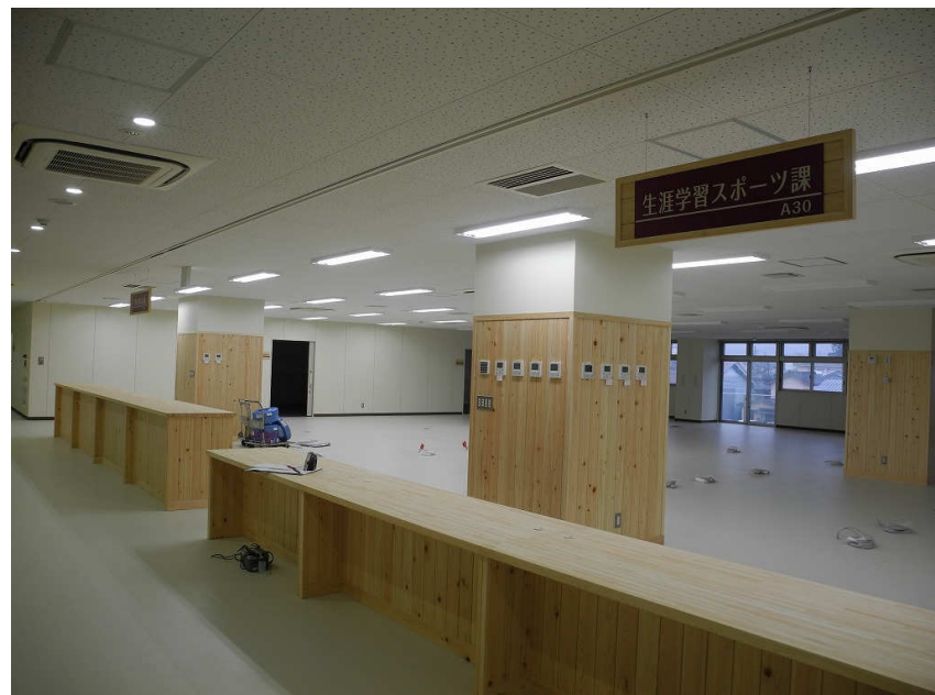
3階 執務室 配線工事
