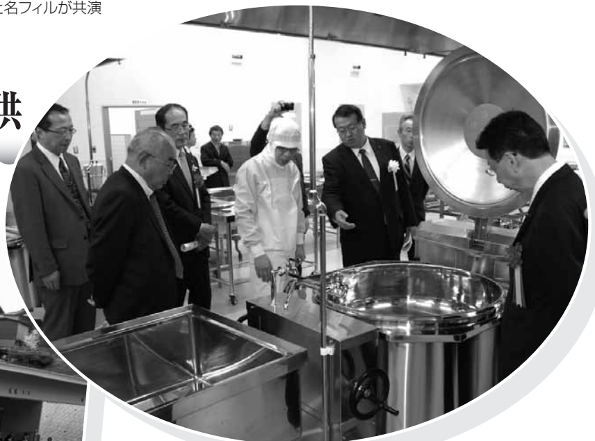
調理室に設置した電気回転釜
