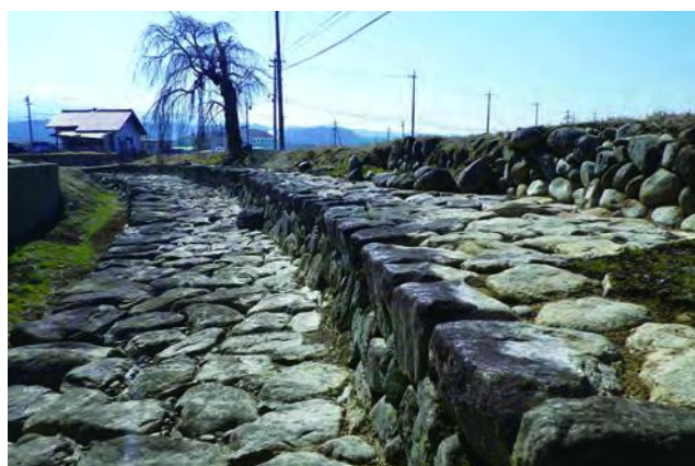
写真 23 座光寺の石川除(北西側から)
