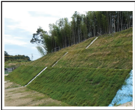
切土法面等の緑化
