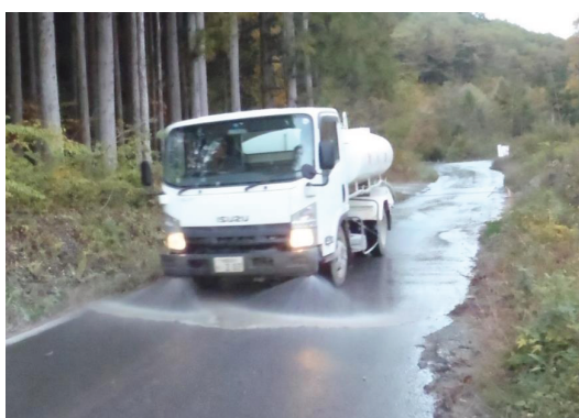
道路の散水・洗浄状況
