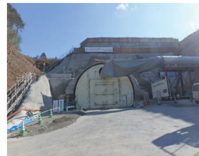
防音扉の設置
