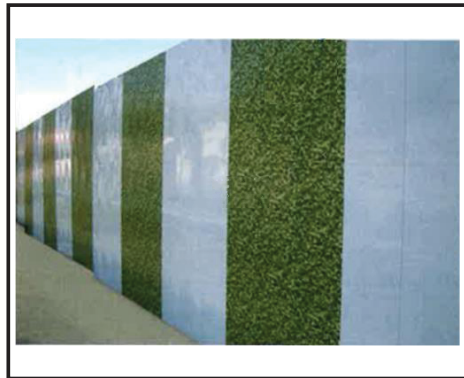
仮設物の色合いへの配慮(仮囲い)
