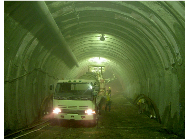
吹付コンクリート
