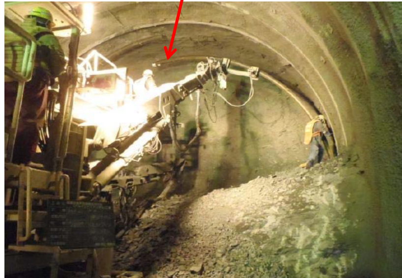
※地山状況により施工を実施
