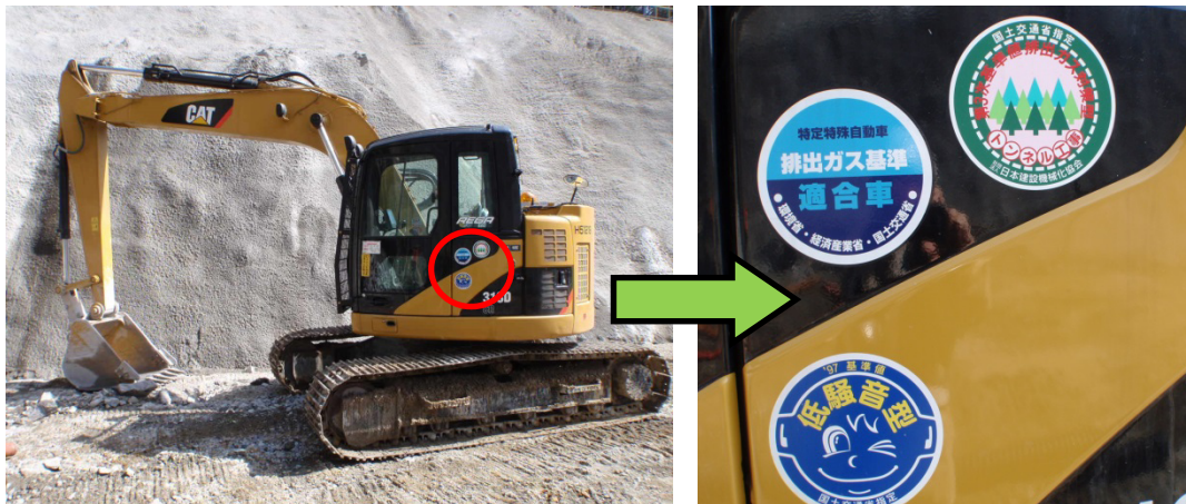
低騒音・低振動・排出ガス対策型建設機械の採用
