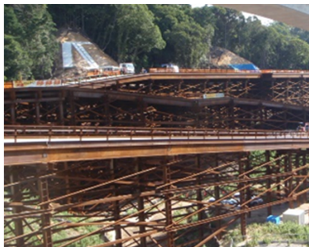
仮設物の色合いへの配慮 (工事用仮栈橋)
