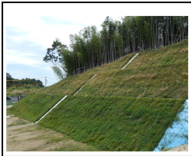
切土法面等の緑化
