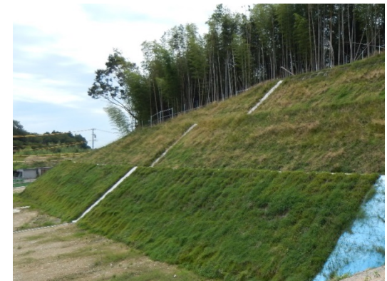
切土法面の緑化
