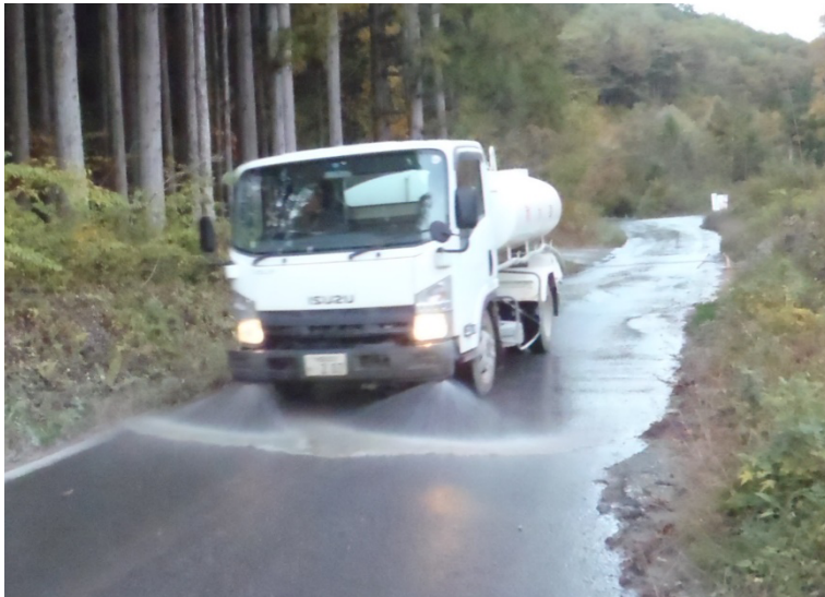
道路の散水・洗浄状況
