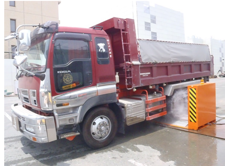
タイヤの洗浄状況
