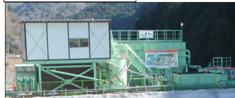
工事排水の処理設備
