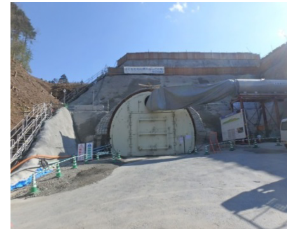
防音扉の設置
