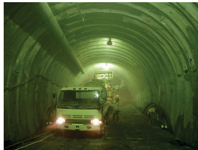
吹付コンクリート
