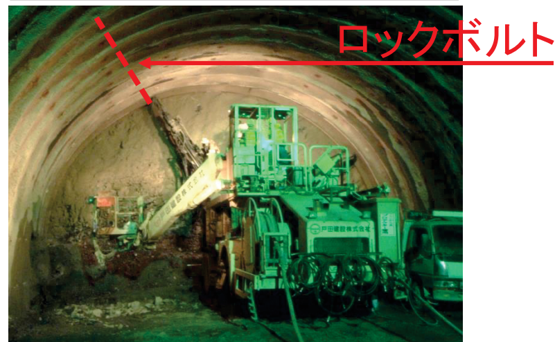
ロックボルトの打設
