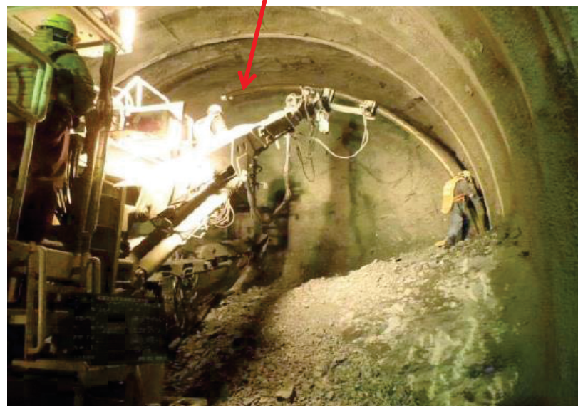
※地山状況により施工を実施
