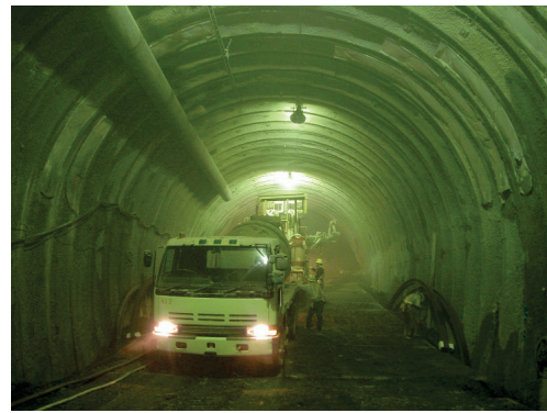
吹付コンクリート
