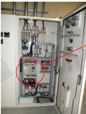
【外調機動力制御盤】
