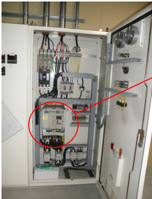
【外調機動力制御盤】
