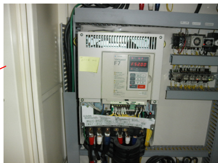
インバータ周波数を変更 1階生産フロア北系統=58 (Hz) 1階生産フロア南系統=52 (Hz) 2階生産フロア系統=56 (Hz)
