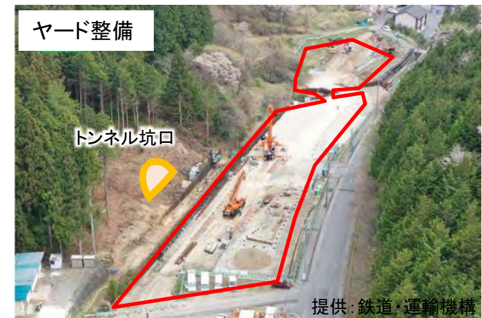
黒田工区 ヤード準備工の現在の様子
