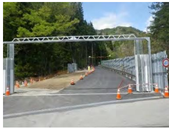
関沢 (くらがりさわ) 川右岸側 工事用道路整備 (済)
