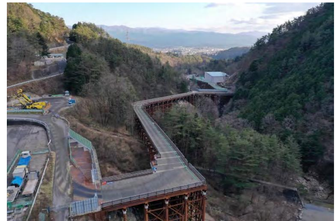
施工ヤード造成
