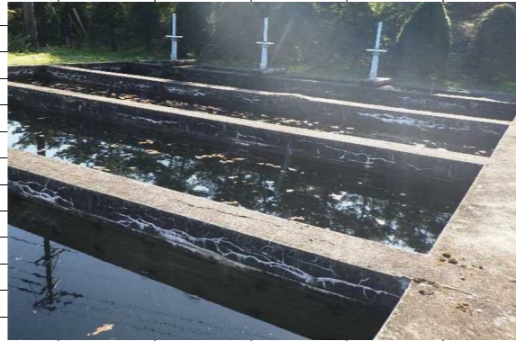
風越貯水池 (撮影R2劣化度調査より)
