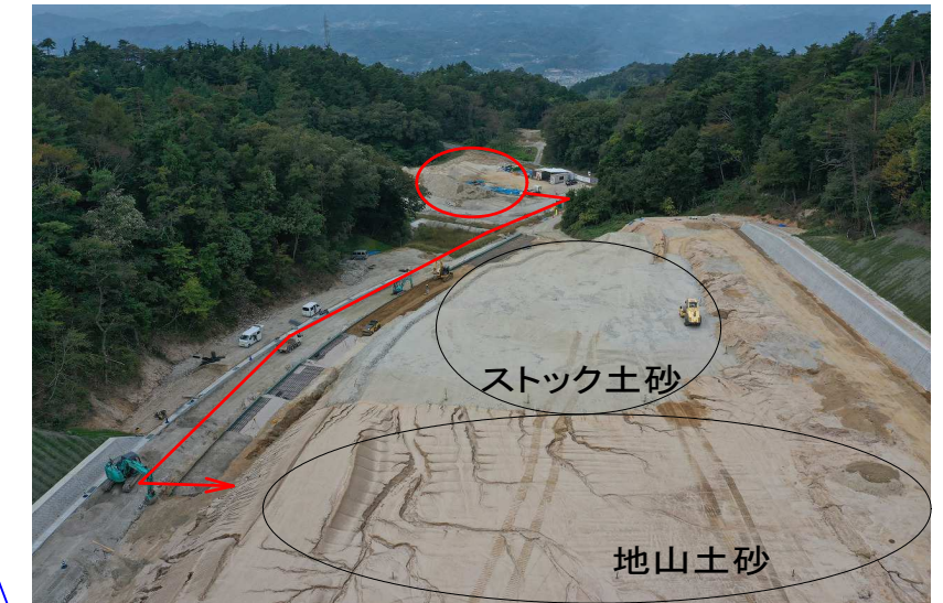
① スtockした仕上げ材の運搬
