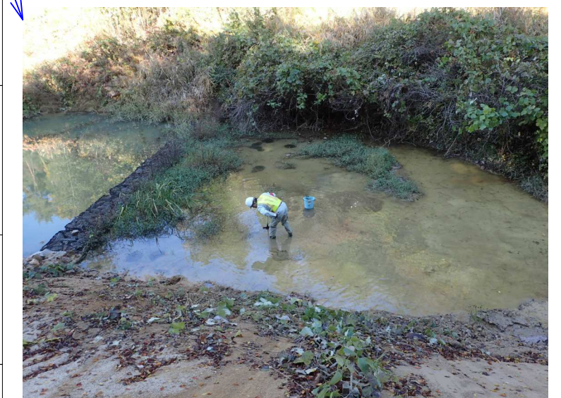
③ 既設ため池への環境保全対策(植物の移植)
