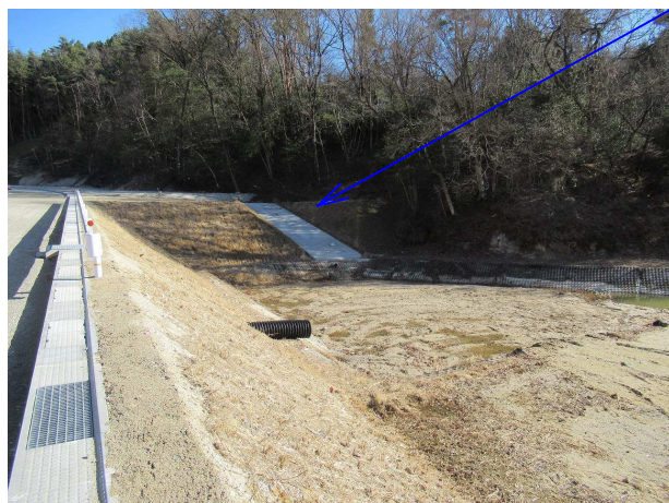
④ コンクリート舗装
