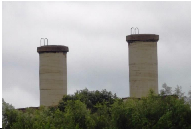
731部隊のボイラー室、巨大な2本の煙突が残る
