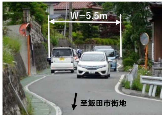
普通車のすれ違いが困難な状況
