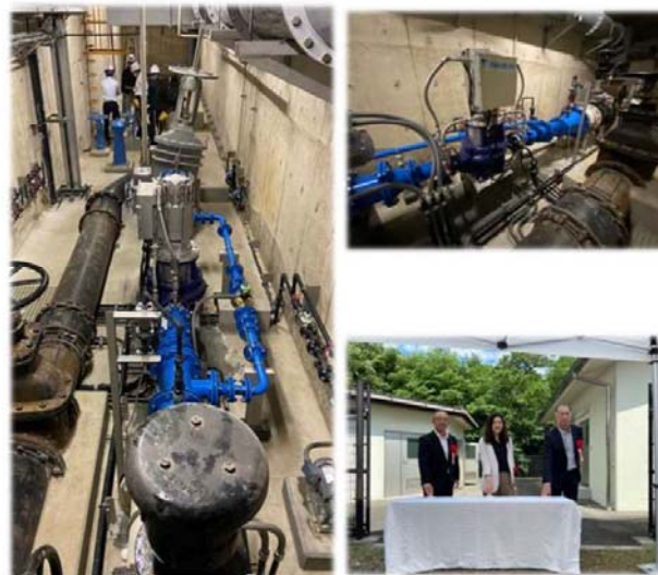
長野市（上野配水池：定水位弁からの置き換え）
