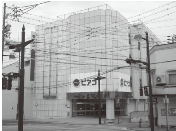
（仮称）飯田駅前プラザの整備予定場所
