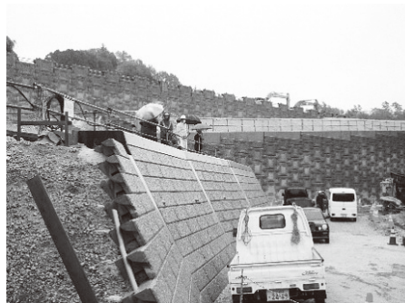
盛土を抑える補強土壁の建設の様子(下久堅)
