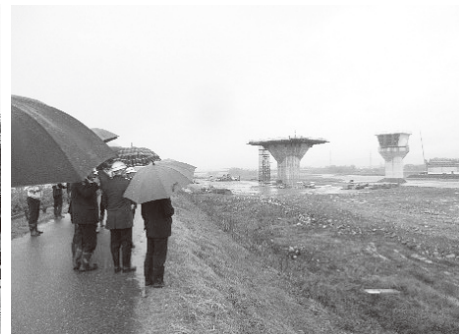
橋脚部建設の様子(喬木村)
