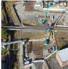
JR飯田線アンダーパス工事 土曾川函渠工事を実施
