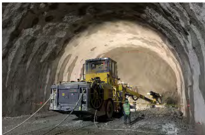
本坑トンネル掘削を実施
