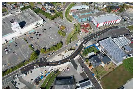
令和5年3月 新戸川函渠工事に着手
