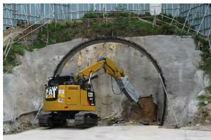
令和5年8月 非常口トンネル掘削開始
