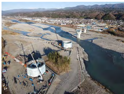
令和5年10月 飯田市側橋脚基礎工事着手
