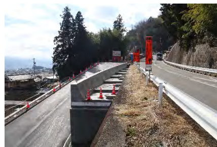
土曾川橋りょう右岸下部工工事 飯沼南地区の市道付替工事 市道五郎田線北側の新設交差点 工事を実施
