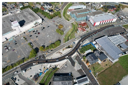
令和5年3月 新戸川函渠工事に着手
