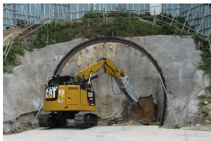
令和5年8月 非常口トンネル掘削開始
