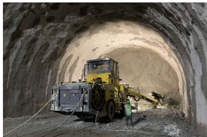
本坑トンネル掘削を実施
