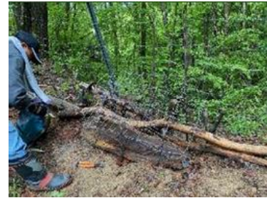
野生鳥獣対策防護柵補修作業
