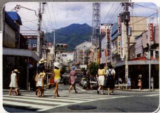
昭和50(1975)年8月、中央自動車道が開通し た日の中央通りを写したものです。銀座通り には開通を祝う横断幕が掲げられています。
