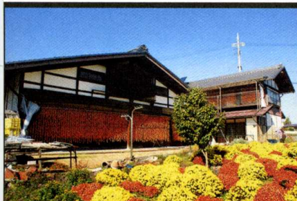
▲本棟造・蚕室長屋を利用した柿簾
