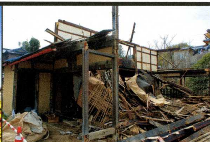
▲建造物解体の様子
