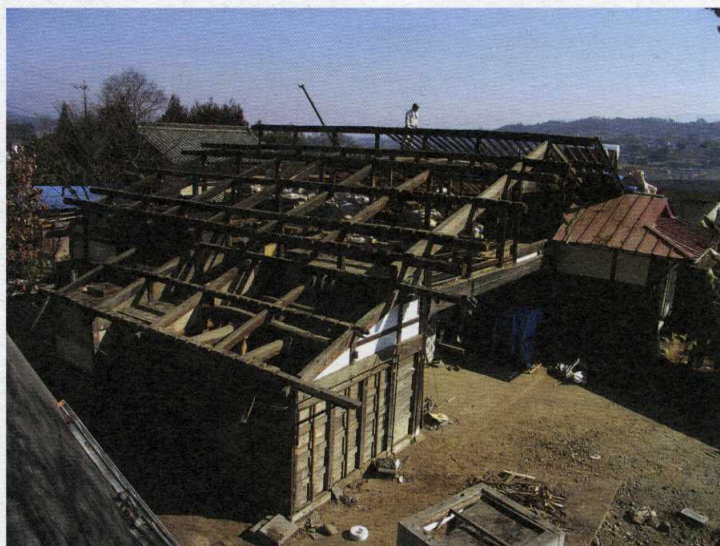
解体中の塩澤家（川路）
