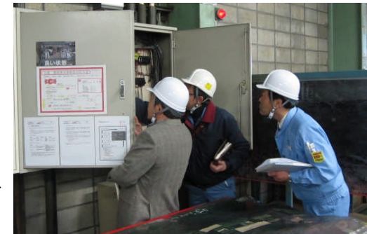
省エネアドバイザーと工場内を確認している様子 →
