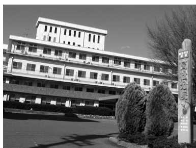
解体予定の旧高松分院
