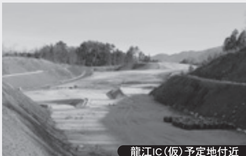
龍江IC(仮)予定地付近
