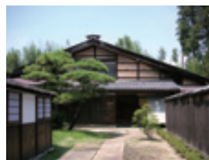
▲飯田市域で現存最古の本棟造
