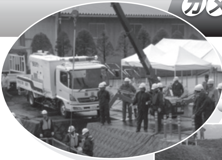
ポンプ車と自走式クレーン
