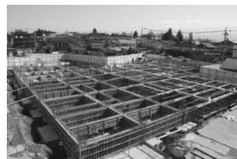
工事が始まった新介護老人保健施設
