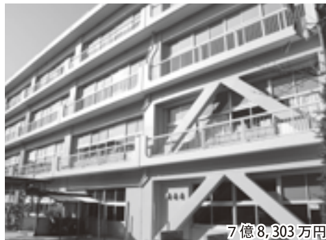
学校施設の耐震化(写真:丸山小学校) 7億8,303万円
