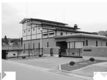
川路浄化センター(川路)
