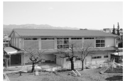
耐震化工事が完了した県小学校
