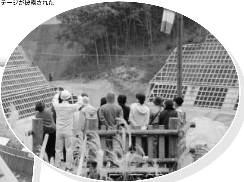
最終処分場建設現場にて
