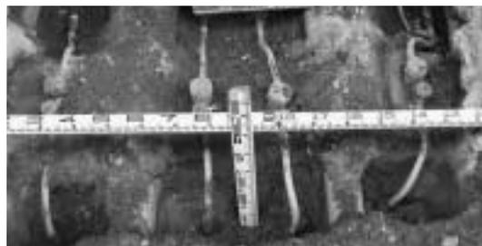
鉛製給水管の布設替え工事
