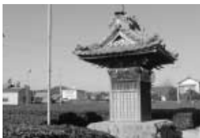
新田組龍燈鞘堂（浜松市上島） 遠州の秋葉街道沿いに多く存在する常夜灯です。集落ごとに燈籠を建てて火の災いのおよばないことを祈るとともに秋葉山参詣の道しるべにもなっています。
