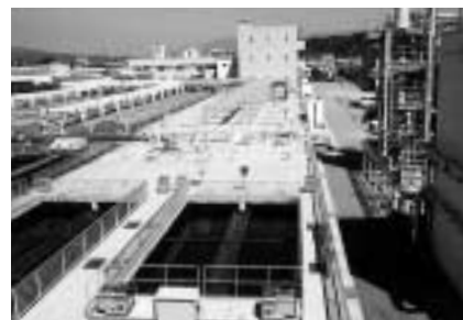
公共下水道の整備 松尾処理場第3系列の完成
