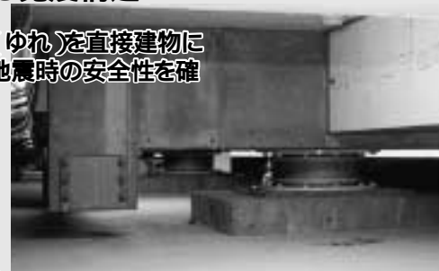
3階と4階の間に設けた免震装置
