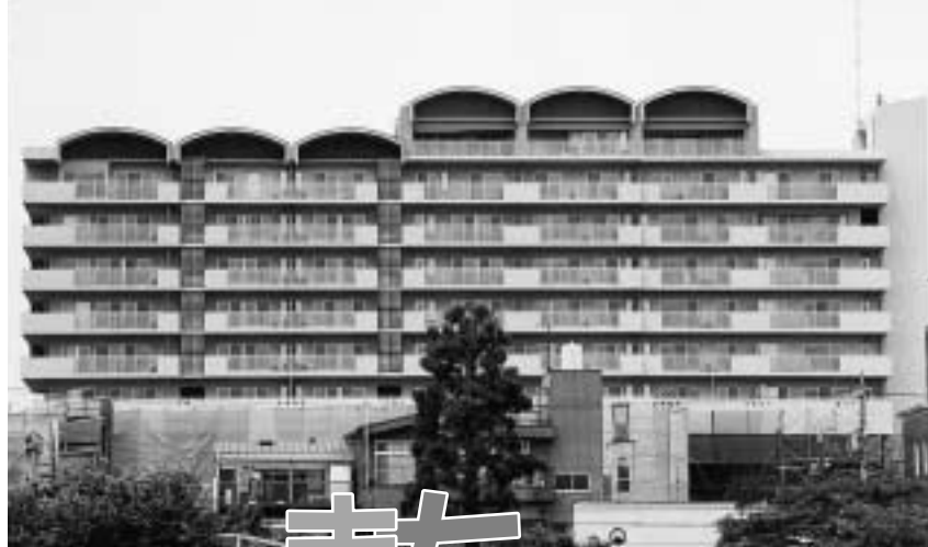
南側から見る住宅部分
