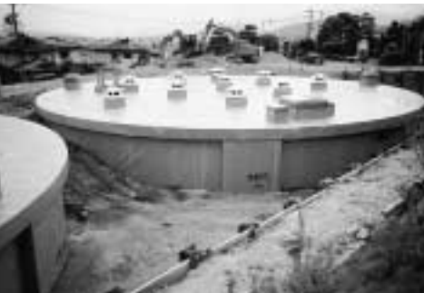
砂払浄水場 配水池増改築工事
