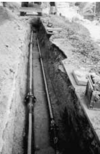
米川2期 配水管工事
