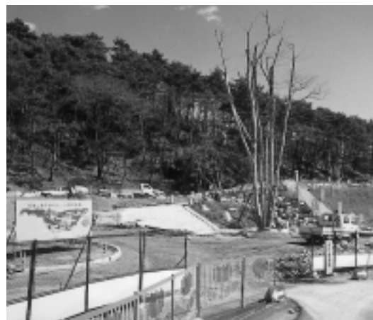
整備が進む風越山麓子供のもり公園
