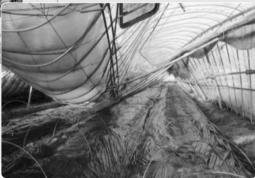
倒壊したパイプハウス
