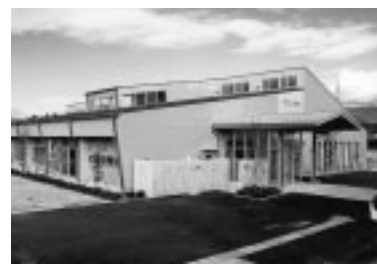
ほっ湯アップルの建設
