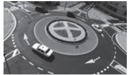
中心市街地道路整備 (ラウンドアバウトほか) 2億5,705万円 (土木費)
