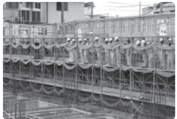
工事現場を見学する高校生
