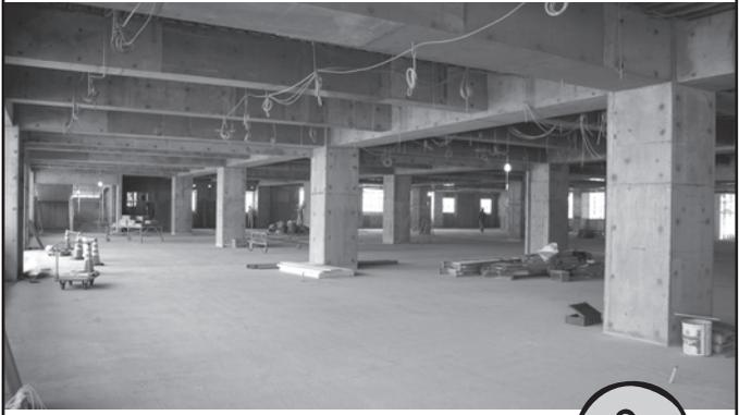
コンクリート工事が終了した地下や1階では、電気・機械設備工事、ドアや窓などの建具工事が行われています。
