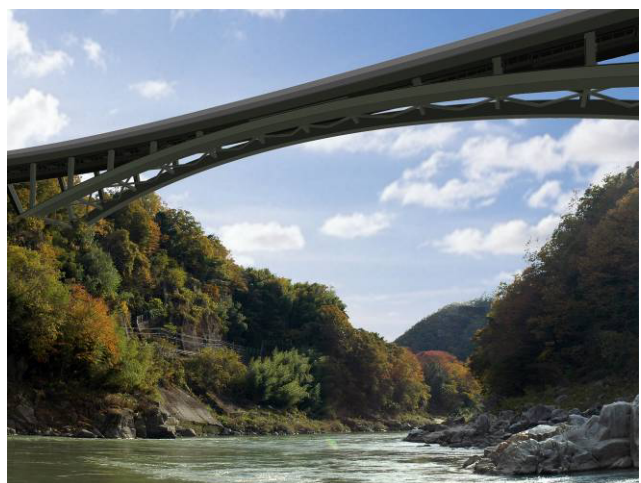
■（仮称）天龍峡大橋
