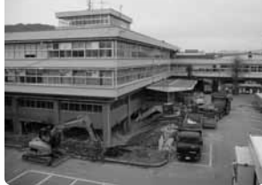
市役所旧庁舎を耐震化
