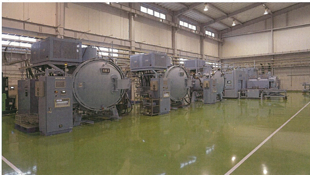
航空宇宙産業クラスター拠点工場熱処理工場棟内部
