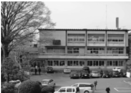
現市役所庁舎(水道環境部棟)
