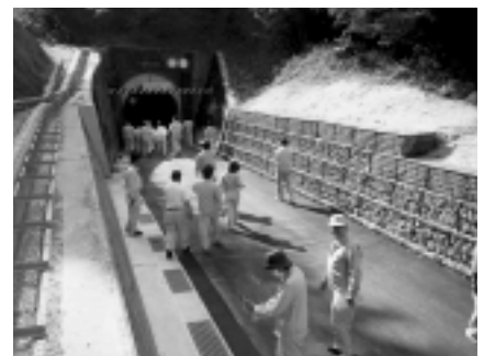
鳩打トンネルの整備状況を視察（伊賀良 林道鳩打線）
