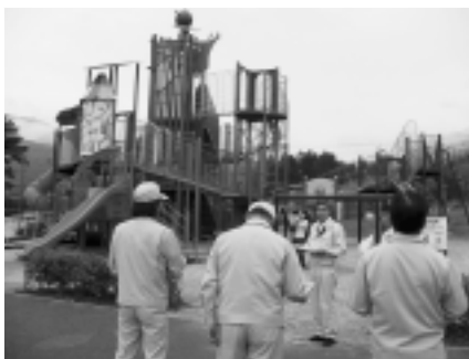
公園整備工事の状況を視察(羽場)
